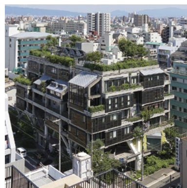
▲ 大阪ガス実験集合住宅NEXT21 スケルトン・インフィルによる二段階供給方式を採用した集合住宅。1993年より四半世紀にわたり継続して居住実験が行われている。 写真提供：大阪ガス
