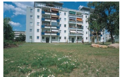
▲解体後の空地に自然を再生する様子(ドイツ/シュベット市) 写真提供: (公財)日本生態系協会
