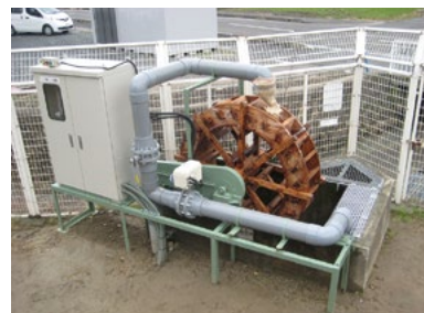
▲ マイクロ水力発電機 写真提供: 株式会社エリス
