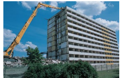
▲シュリンクング・ポリシーによる建物の撤去風景(ドイツ/シュベット市) 写真提供: (公財)日本生態系協会
