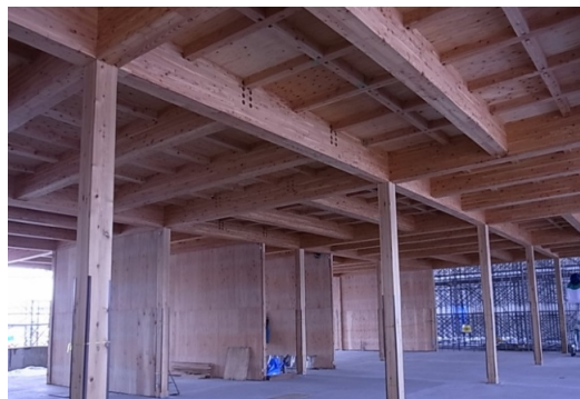
中断面集成材と住宅用梁受金物による6mグリッド2階床組+高倍率耐力壁
