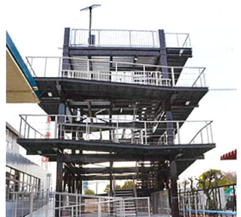
津波避難タワー（SGタワー）
