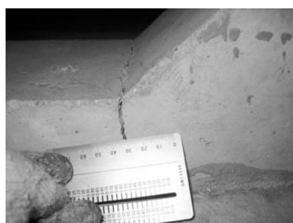
↑人口口の亀裂幅は2.5mm 主筋がなく切断されていた↓
