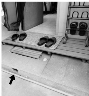
写真 2 玄関の敷きブロックの水抜き孔
