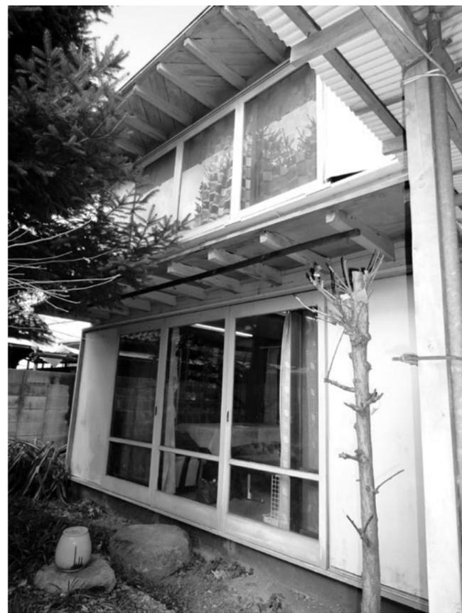
写真 3 南面の外観 庇の斜め貼り2階の突出梁構造 ホモゲンホルツの戸袋の仕上げ
