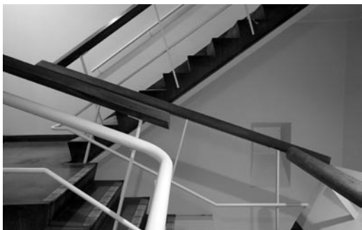
増築された搭状の階段室の内部
