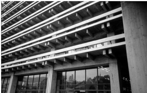
南側からの庁舎外観
