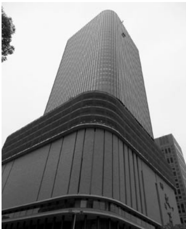
写真3 フェスティバルタワー
