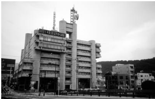
甲府駅側から見る建物全景
