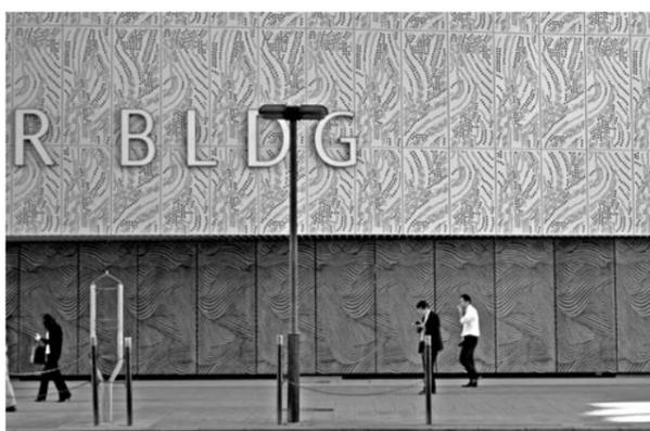
外壁詳細：上部アルミパンチングパネル、下部 GRC（堺筋の波模様）
