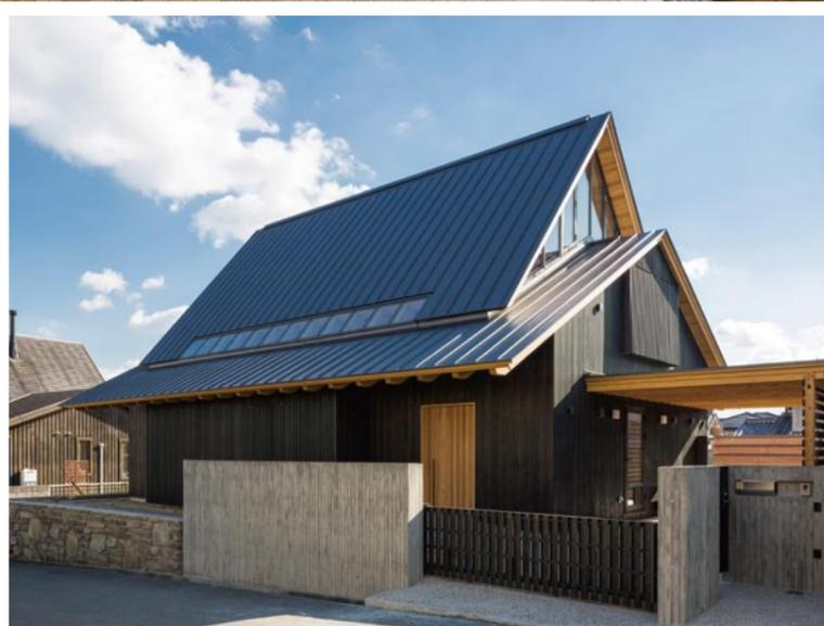
二層分の大空間に大和棟の形態を引用した大屋根、急勾配の上屋根と緩勾配の下屋根が重なり合った屋根を特徴とした住宅である。この住宅における試みは、屋根によって、住まいを一つのまとまった場として領域化しつつ、その領域化された場を差異化することであった。内部空間の空間的自由度を確保するために棟を支える柱は設けず、屋根は外壁周りの柱と壁に寄せ掛け、その結果、内部空間全体に構造的な秩序をもたらすことができた。重なり合う二つの屋根が雲のようにひとつに空間を包み込み、場所を規定し、重なり合う二つの屋根と間から透過、反射した光が内部に柔らかな光の場をもたらしている。
