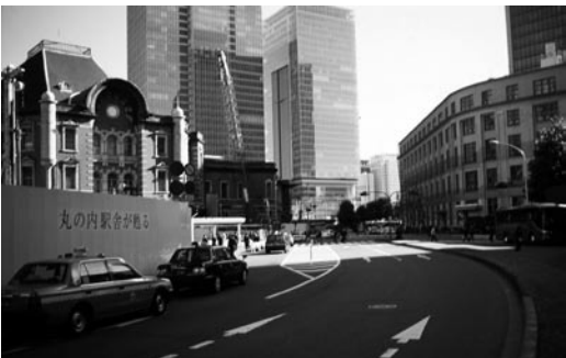
「丸の内駅舎が甦る」と書かれた仮囲いと解体直前の東京中央郵便局
