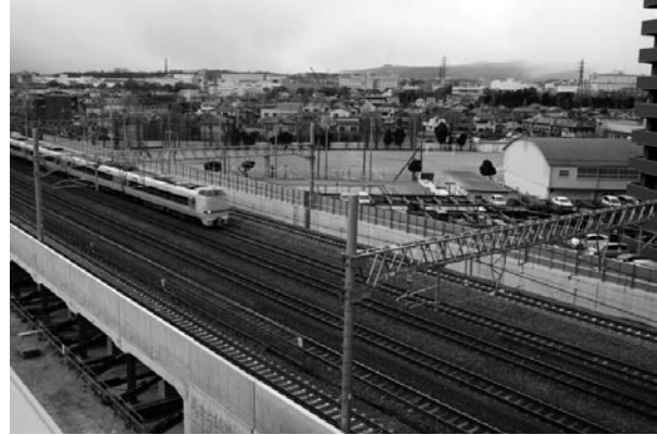
建設が進む(仮)JR 総持寺駅付近（京都方面から望む）
