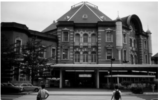
復元工事前の東京駅丸の内北口の外観
