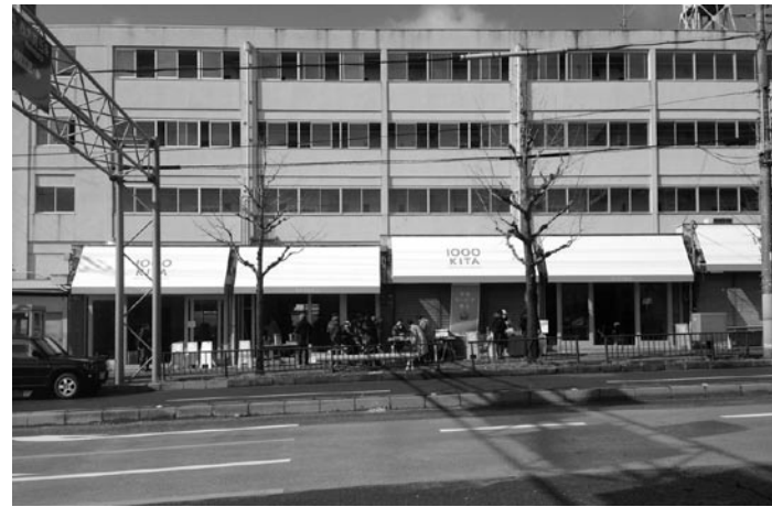
改修後の1000KITA外観、前面道路は千本通
