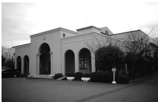
正面玄関入口を見る
