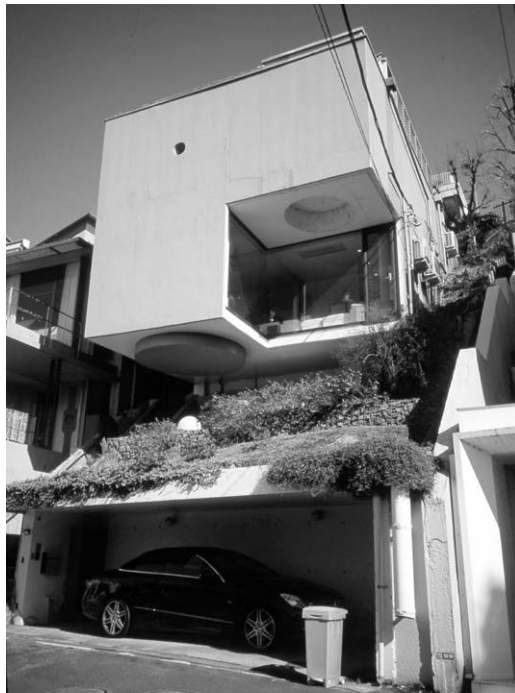
西側の前面道路から見上げる建物全景
