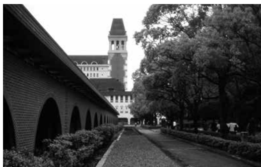
アプローチ路から見る北側外観
