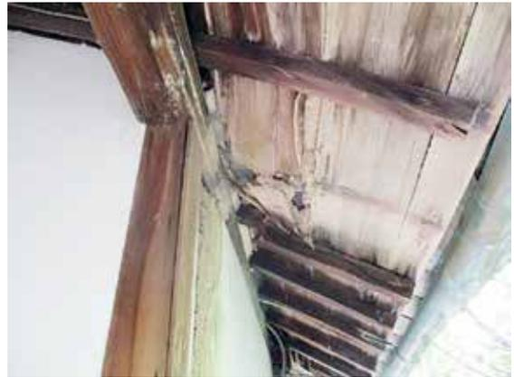
写真 4-6 軒裏板の腐朽
