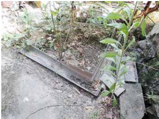
写真 4-7 雨樋の脱落
