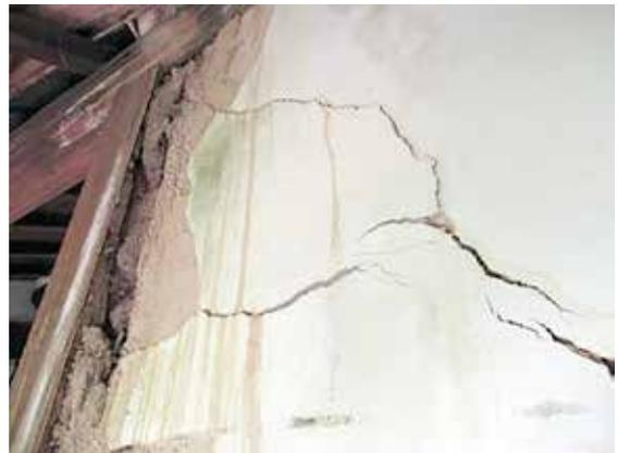
写真 4-8 外壁の大きなひび
