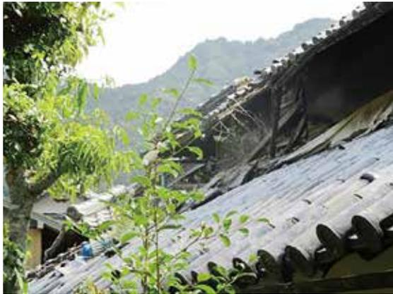
写真 4-5 屋根の陥没
