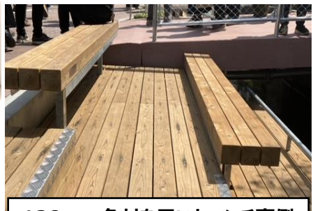
120mm角材を用いたベンチ事例
