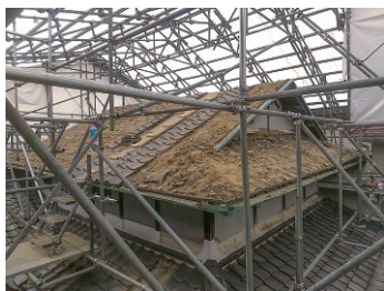
▲離れの屋根の修復状況
