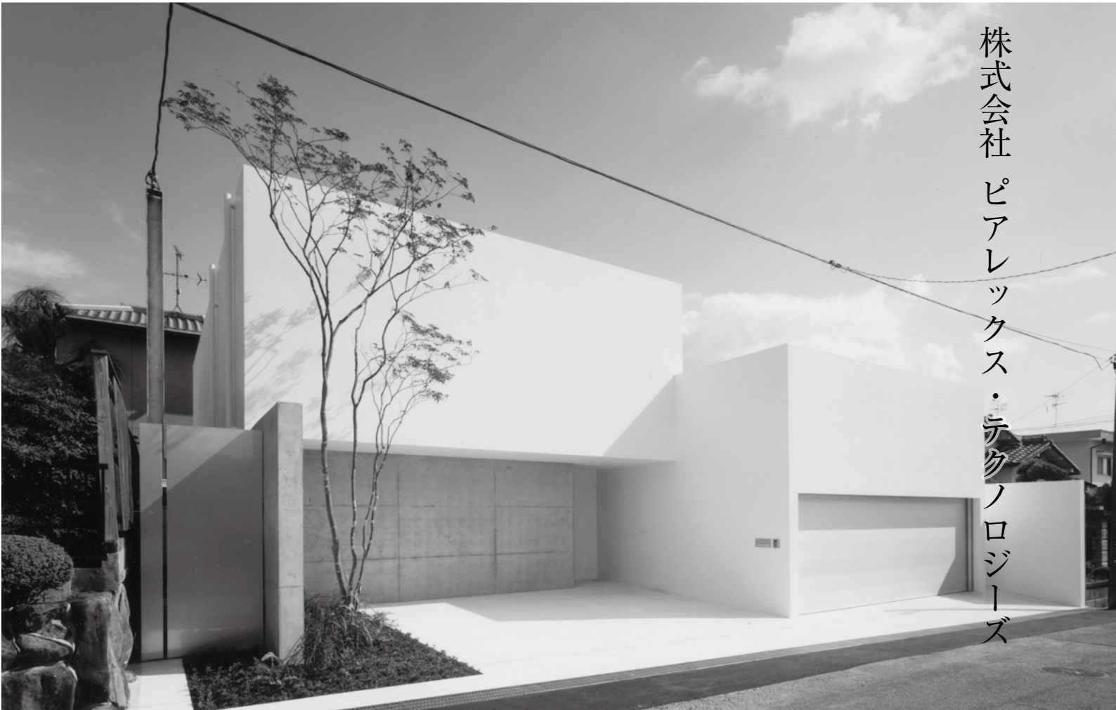
「ピュアコート」を外壁に塗布した住宅：「羽曳野の家」設計：坂本昭・設計工房 CASA
