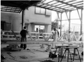
②グラウンドに設置した作業架台の上で、①のトラス梁を2つ1組で山型に組み、下弦材を付ける。
