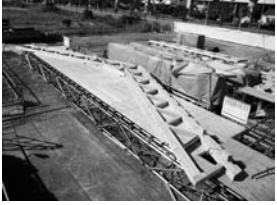
③2階鉄骨梁の上に、組柱を腕木まで建て、柱同士を横繋ぎする組開差を組む。壁筋交いと①で地組みした桁トラスを納める。
