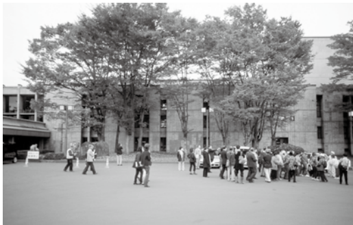
ホール棟の南面外観 左側に車寄せ棟の庇が見える
