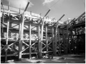
④集積用架台に仮置きした②のトラスをクレーンで吊り上げ、桁に納める。
