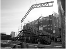
⑤メイン・サブフレームに①の桁行き方向の母屋・棟トラスを渡し組み込み、小屋筋交いを入れて骨組み完成。
