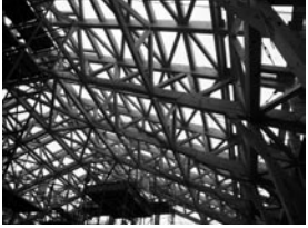
⑤メイン・サブフレームに①の桁行き方向の母屋・棟トラスを渡し組み込み、小屋筋交いを入れて骨組み完成。
