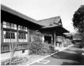
式台構えの玄関 東側外観
