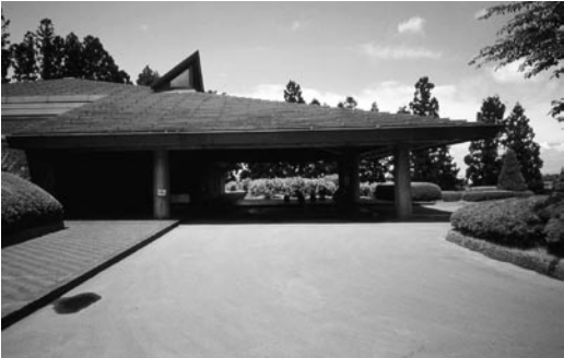
勾配屋根のかかる車寄せ
