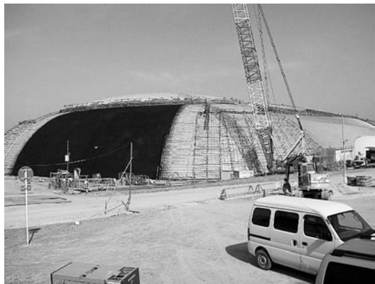
大林式緑化工法にて施工中のビーンズドーム（下2枚）
