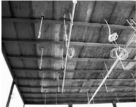
既存竿縁天井を温存し、直下には天井ボードを新設
