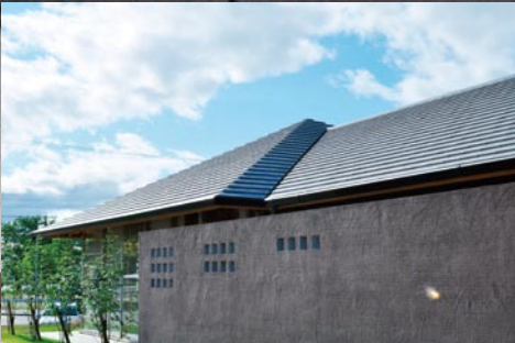
施工例：浄谷コミュニティセンター（三木市）
