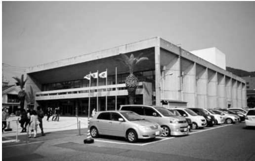
折板構造の外壁と屋根で構成された公会堂の外観
