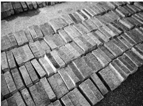
ひとつひとつ取り外し、モルタル除去後洗浄した
