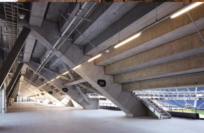
Jリーグ・ガンバ大阪の新たな本拠地となる国際基準のサッカー専用競技場。「寄付金でつくる日本初のスタジアム」として建設され、ピッチまで最短7mの劇場型観客席により、欧州水準の観戦環境を実現した。4万席を覆う屋根には、たて・よこ・ななめの架構「3Dトラス」と屋根免震構造を採用し、約40%の鉄骨軽量化に成功している。芝育成のため、南側をガラスで構成した低い屋根で日照確保し、観客席下の全方位に通風口を設けた。オールLEDのグラウンド照明、0.5MWの太陽光発電など環境技術を備え、建物のコンパクト化とメンテナンスレスの材料を追求することで、持続可能なスタジアムを目指している。大平滋彦・浜谷朋之
