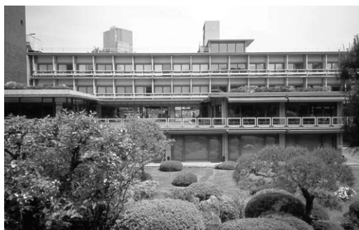
南側からの建物全景
