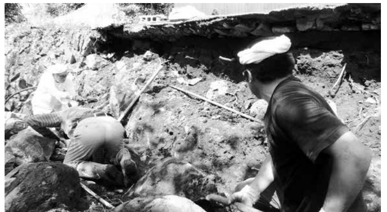
土木・建築専門家とボランティアの擁壁の応急処置（2016年5月30日）
