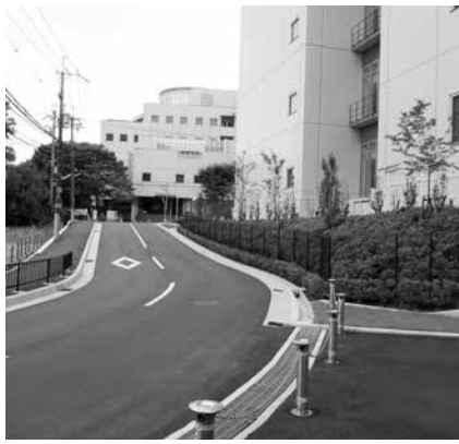
町道広瀬桜井幹線(バリアフリー化後) [写真A]
