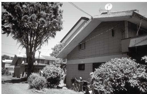
南西から見る住棟
