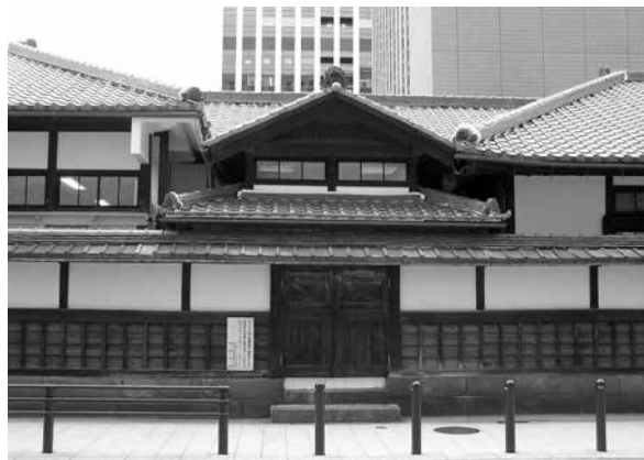
便所棟の屋根
