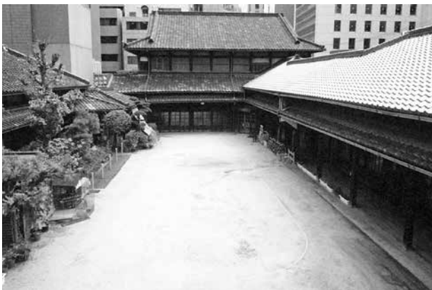
建物廊下とレベル差のない園庭
