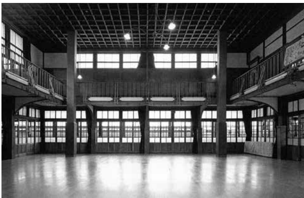
遊戯場。木造の建物に鉄製のギャラリーが追加された。両隅の通し柱は、構造補強として平成元年に設置したもの。
