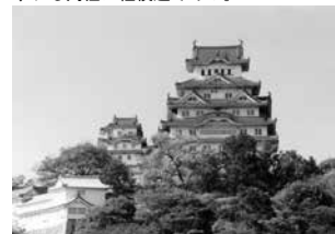
写真6 姫路城。のびやかなデザインに見えるが建築としては開口部の小さい閉鎖的なつくりである。
