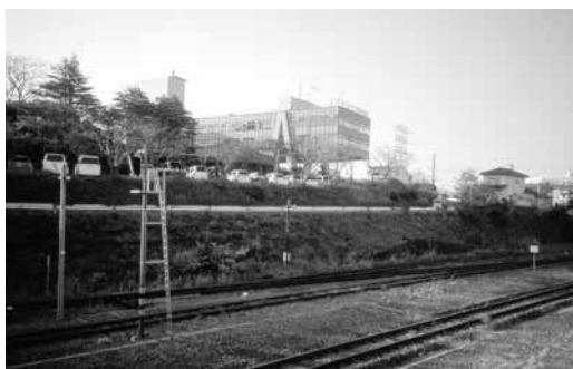
山陰本線の線路越しに見る建物全景
