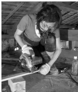
② ゲストハウス由苑のリノベーションの様子。スタッフも参加しながら工場跡・ビル・料亭などを改装し、宿泊施設として運営。
