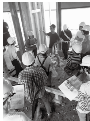
耐震改修見学会の様子
