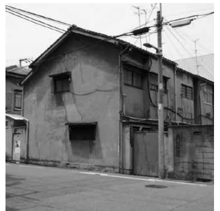
再生前の小川文化北棟
