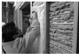
写真3 木小舞土壁に繊維系断熱材を充填する様子
