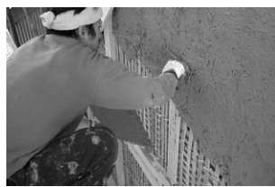
写真2 竹小舞土壁で新築する家は、京都でも数件しかないと言われている。
