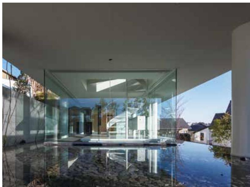
建物は23.2m\*6.6m\*4.7mのシンプルな白い箱とし、それを8本の丸柱で地面から持ち上げた。建物を浮遊させることで、隣地から解放されたすばらしい見晴らしを獲得し、かつプライバシーの確保にも貢献している。1階はピロティの浮遊感を損なわないよう、ガラス張りの玄関と収納のみとした。周囲にめぐらせた水盤と植栽は、クライアントが収集されている美術品とが繋がった、開放的なギャラリー空間として訪れる人を楽しませてくれる。2階は眺望が広がる東面のみ大きなガラス建具とし、それ以外は極力閉じることで、開放的でプライベートな住まいを実現させている。
