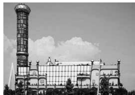
舞洲スラッジセンター外観
