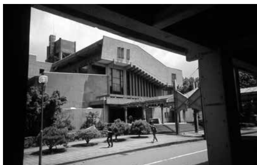
北西側からみた建物外観
