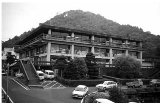
南西側から見る事務棟外観
