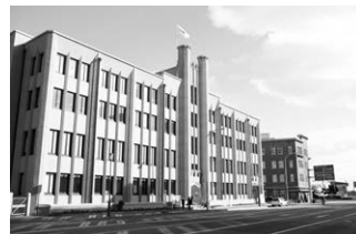
写真4 KIITO旧館(1927年築)の外観(撮影:伊東俊介)
