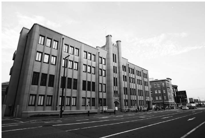
旧神戸市立生糸検査所（旧館）（撮影：伊東俊介）
