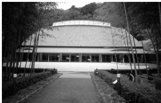
南東から見る建物全景
