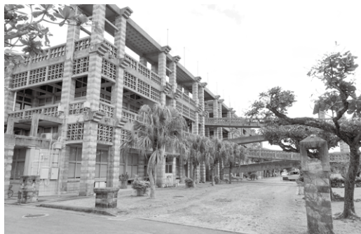
柱頭に載っていたシーサーが撤去された南側ファサード外観
