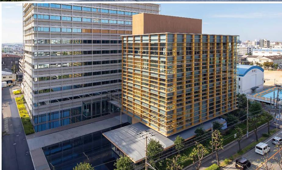
ボイラー・プラントメーカーの本社研修・事務所。建築主の事業は木との親和性が高く、木を用いた建築としたいという背景から、木造の採用に至る。本計画では木でしかできない建築を追求するのではなく、「鉄・RCでしかできなかったものを木でつくる」ことを目指した。防耐火要件、耐震性能といった課題はそれぞれ「耐火集成材柱」、「CLT耐震パネル」、「免震」という要素によってクリアした。外装は集成材ダブルスキンのスリムな接合部設計により高い透明感を生み出している。この都市型木造への取り組みが木のさらなる可能性を発信し、「木造でも出来るビルディングタイプ」が広がっていく契機になることを期待している。
