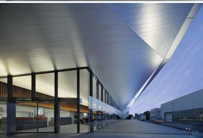
全てのディーラーで全ての車種を販売する事になり、それを「一つに包む」というコンセプトで、このショールームを計画した。外装材を全てアルミに統一、天井照明、空調をサッシ際に集約し、大きな一枚の紙から折られた形態を表現した。大屋根に折り目を入れることで屋根全体の構造強度を上げ、片持ち屋根先端のたわみ量を減少させた。16m×70mの大屋根無柱空間は、展示車や商談席の多様な配置に柔軟に対応でき、外部の天井材、床材を内部に連続させ、内外の一体感と広がりを出した。軒の出と高さの決定には日射シミュレーションを行い、営業開始以降は日射が室内に入るのを避け、ガラスの大開口から自然光を取り込み、大屋根で内外が一体となった開放的なテラスのような空間の中で車と人との繋がりを実現した。
