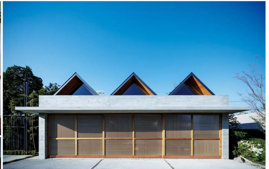
敷地は5年前に竣工した住宅のアプローチ横の菜園として使用していた所に位置し、要望された会社事務所兼ギャラリーが建っている。周辺が住宅地として整備されつつあり、街並みを考え、外壁を既設住宅のコンクリート杉板型枠打放しに合わせた。コンクリートの硬さを和らげると、優しさが感じられるように、既設住宅では使っていない木を、3つの矩形三角屋根に垂木天井として使用し、外部から三角のハイサイライト越しに垂木天井が垣間見えるようにした。内部は、床をチーク無垢材、飾り棚、ソファ、音響スピーカーなどを設置し、オフィス&ギャラリーに相応しい多目的空間を意図した。
