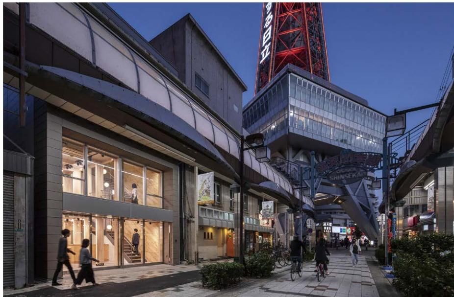
通天閣の新たな観光拠点としての物販店舗である。通り抜けができる平面プランとし、通天閣を中心に新世界に広がる放射状の街路に新たな賑わいの小路を加えることを目指した。へ字型の敷地形状にあわせ木造門型フレームを配することで、店舗幅を最大限確保すると共に、通り抜け空間として奥へ引き込まれる視覚的効果を演出した。耐火・準耐火建築物でない「技術的基準適合建築物」とすることで、「木架構の現し」「堅穴区画不要」等を実現し、狭小敷地ながら豊かな空間を生み出した。建物が密集する地区において、通り抜けができる風通しの良い店舗空間が、ニューノーマル時代の新たなモデルのひとつとして街に展開されることを期待している。
