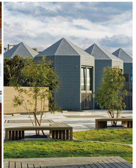
JR線駅前に建つ電子部品メーカーの研究試験施設である。旧建物での製品試験を継続しながらの建替計画であったため、路地(接道幅2m奥行き28m)奥での工事となった。大型重機の使用が不可能な状況から人力での施工が前提の小部材を用いた木造建築とし、また、今後の増築の有無が不確定な状況を考慮して、増殖可能性を孕んだ「八角形の連続体」とした。旧建物解体後の外構計画にも建物同様の八角形を用い多くを緑地とした。この緑地が今後の増築スペースとして確保されつつも、現状では雑然とした周辺環境に対しヴォイドとグリーンを提供することとなり、機能的であることや常識的であることを超えた企業自らの姿勢や想いを表象している。(岸下真理+岸下和代)
