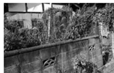
施工前の写真
