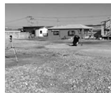
撤去工事の完了写真
