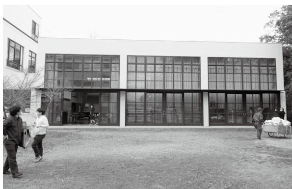
小体育館の南側からの現状外観
