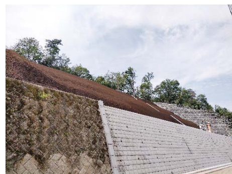
工事の進捗(豊能町光風台6丁目緑地)
