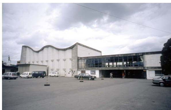
西側から見た正面外観全景。 一九九七年六月七日撮影
