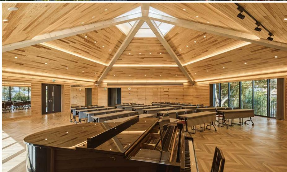
音楽室、視聴覚室、スタジオの3棟と中庭キャノピー、連絡通路で構成。建物を変形の寄棟屋根に分棟することにより、本館教室への圧迫感をやわらげ、日照や通風を妨げないように配慮。中庭キャノピーの下では大型鏡にてダンス練習もできる。音楽室、視聴覚室は反響を抑えるように平行面のできない五角形の平面。頂部トッライトは自然採光とともに、サーキュレーション機能を持ち、上部に滞留する暖気を、夏季は外部に、冬季はサーキュレーターにより下部に排出する。音楽室棟の天井・壁は地産材の吉野杉板貼り、照明は調光・調色が可能で、様々なシーンでの演出が可能。視聴覚室棟の屋根頂部には、法隆寺の鳳凰をモチーフとした風見鶏を乗せた。
