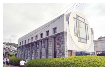
不知火館 全景外観
